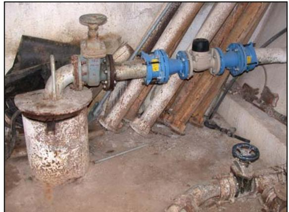
**3. "Sondeo de El Chorro" CA23073003 (213770008):** Tiene una profundidad de 121 m y un diámetro de perforación de 513 mm. Se sitúa a cota 1.040 m s.n.m..Está entubado con tubería metálica de 400 mm de diámetro.
