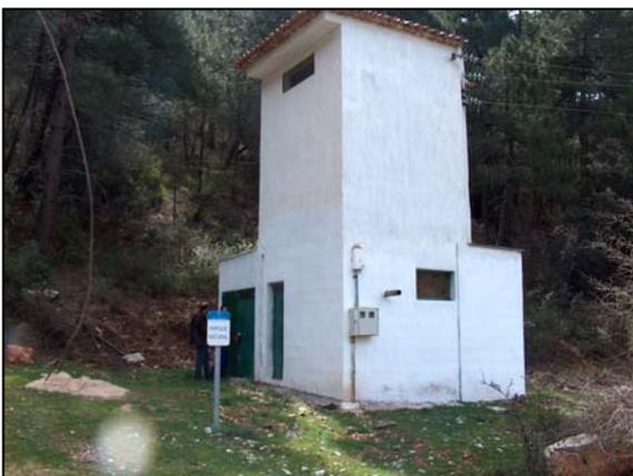
Su caudal de explotación es de aproximadamente 12 l/s. El nivel dinámico no se pudo medir en la encuesta de cuantificación por no disponer el sondeo de tubería piezométrica. Está instalado con una electrobomba sumergible de una
