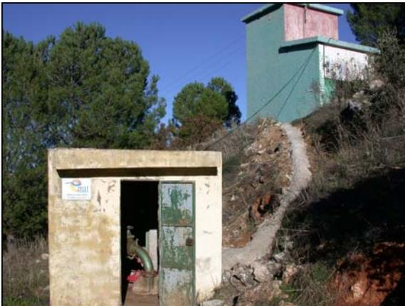
Su caudal de explotación es de 7 l/s. El nivel dinámico se situaba el 30 de noviembre de 2006, según el informador local, próximo a los 158 m de profundidad, a una cota aproximada de 722 m s.n.m.. Está instalado con una electrobomba sumergible de 90 C.V.. La tubería de impulsión es metálica.
