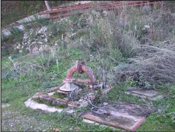
Su caudal de explotación, según referencias bibliográficas, es de entre 3 y 10 l/s. Está instalado con una electrobomba sumergible de potencia desconocida. La tubería de impulsión es metálica.
