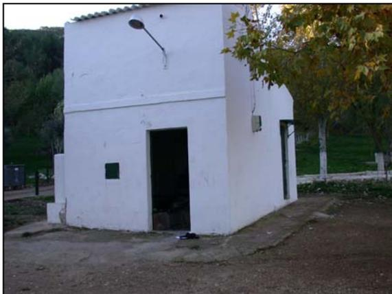
El caudal de explotación del sondeo Santa Ana II es de 0,5 l/s según la documentación consultada. El nivel dinámico se situaba el 30 de noviembre de 2006 a 51,3 m de profundidad, a una cota aproximada de 729 m s.n.m.. Está instalado con una electrobomba sumergible de 3 C.V.. La tubería de impulsión es metálica.
