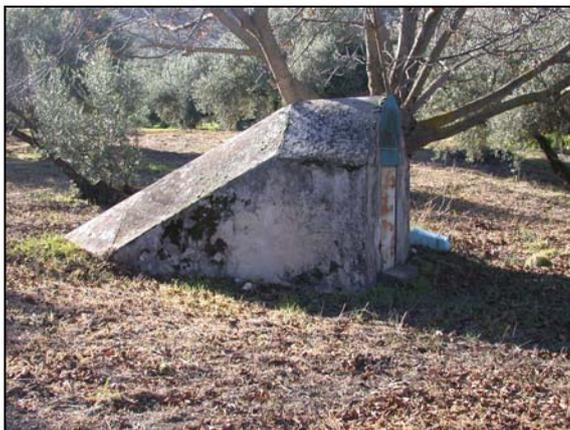
Tiene un caudal muy variable habiéndose registrado desde 0,1 l/s hasta 30 l/s. La captación consiste en dos galerías de las que una tiene una longitud de 30 m y de la otra se desconoce la longitud.
