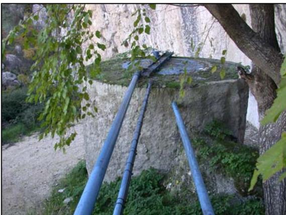
Su caudal de explotación es de 1 l/s. El nivel estático se situaba el día 30 de noviembre de 2006 a 18,46 m de profundidad, a una cota aproximada de 642 m s.n.m.. Está instalado con dos bombas sumergibles de 10 y 5 C.V. que funcionan dependiendo de la altura de la
