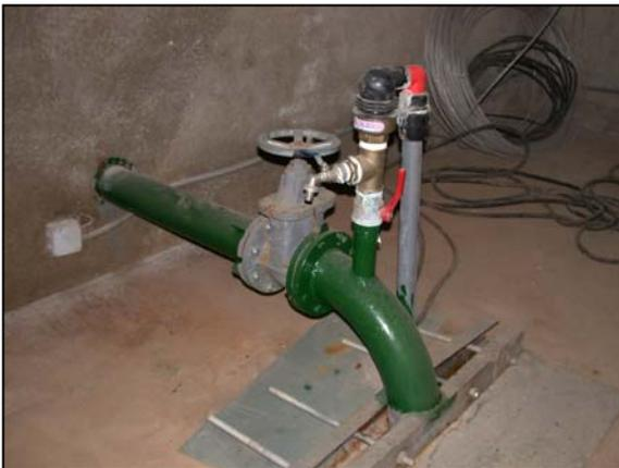
No se ha podido llevar a cabo la encuesta de cuantificación ya que el sondeo no dispone de tubería piezométrica ni de caudalímetro. No obstante, según la información facilitada por la empresa concesionaria del servicio, el volumen extraído del sondeo en 2006 fue de 547.545 m<sup>3</sup>.
